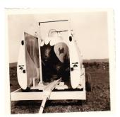
Somit war Ziel eins erreicht. Brauchte es noch eine Winde und einen Ort, um das Flugzeug und die benötigte Werkstatt unterzubringen. Mit starker Unterstützung der ortsansässigen Firma A&C Kosik, wurde in vielen Arbeitsstunden die erste Winde des Vereins auf einem Militärfahrzeug erbaut. Aufgrund der fehlenden Leistung konstruierten die Mitglieder bald eigens eine zweite Winde, die sich aus einem schrottreifen Opel Blitz Lastwagen, einem Omnibusmotor und einer Turbo-Kupplung zusammensetzte.
